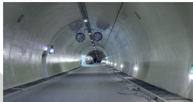
D1 Tunel Višňové (Contract management a príprava akcelerácie)
