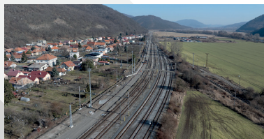
ŽST Hronský Beňadik - ŽST Nová Baňa - rekonštrukcia (Contract management)
